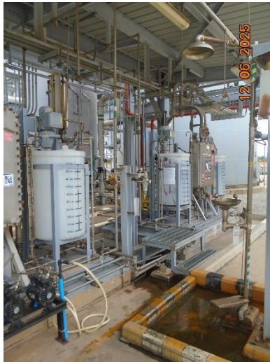
ภาพที่ 2-23 ตัวอย่างภาพถ่ายจุดชำระล้างร่างกายและล้างตาฉุกเฉินในบริเวณที่มีการขนส่งหรือกักเก็บสารเคมี
