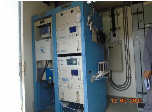
ภาพที่ 2-2 ตัวอย่างภาพถ่ายระบบตรวจวัดคุณภาพอากาศที่ระบายจากปล่องระบายอย่างต่อเนื่อง (CEMS)
